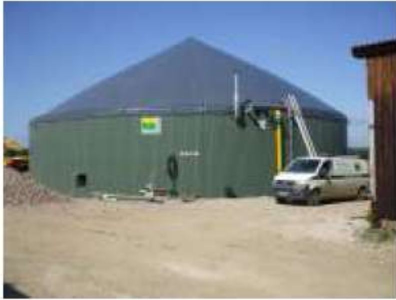
图 2-2 发酵、储气一体化装置（池体为钢结构）
